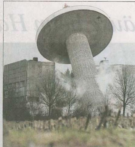
Am 18. Januar 2005 hat Sprengmeister Johann Eggert kurzen Prozess gemacht: Mit 16 Kilo Sprengstoff hat er den 47 Meter hohen Radarturm der Deutschen Flugsicherung „hingelegt“. 200 Menschen sahen zu. Fotos (2): JELONNEK
